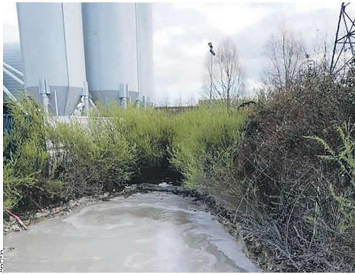
Vinci déverse ses eaux usées dans la Seine à Nanterre.
