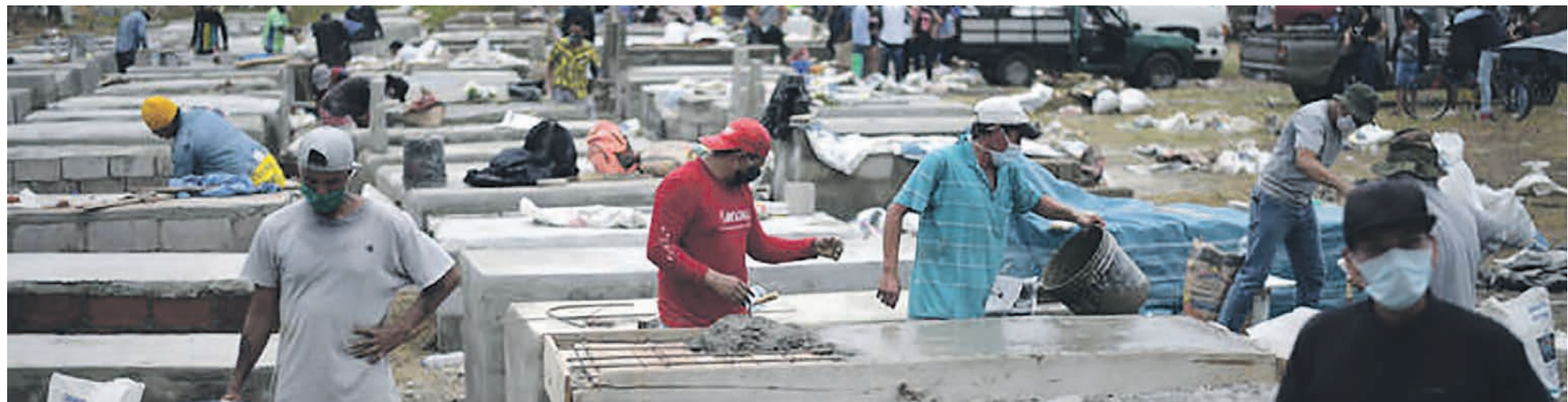
Construction de caveaux en Équateur.
