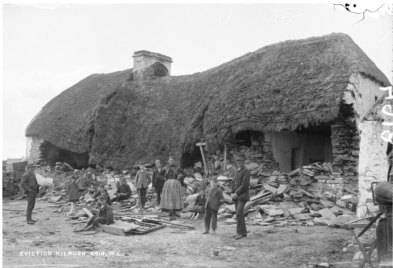
Une maison paysanne détruite au bélier par la police, lors d'une expulsion dans le comté de Clare en 1888.
