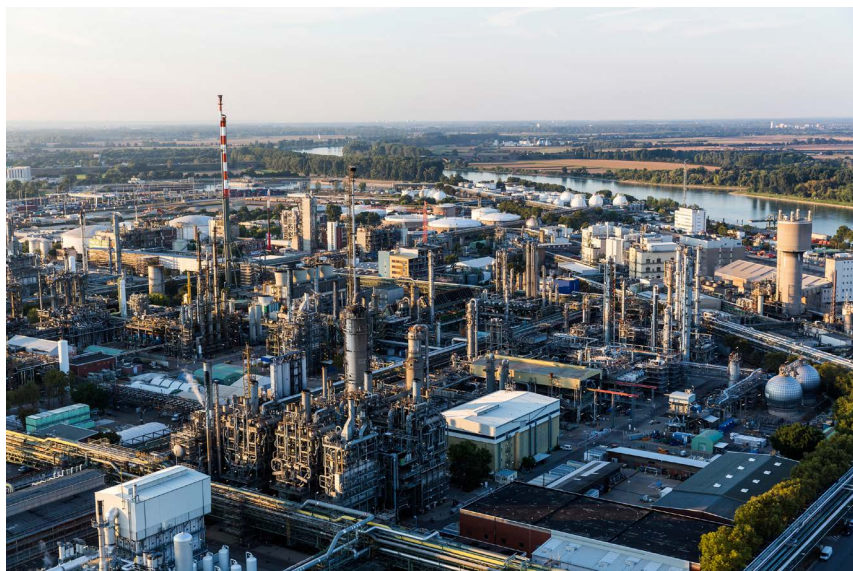
Plateforme chimique intégrée de BASF à Ludwigshafen, en Allemagne.
